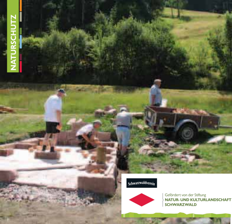
↑ Beim Herrichten des Fußbodens mit Sandsteinplatten und Holz war Genauigkeit erforderlich
